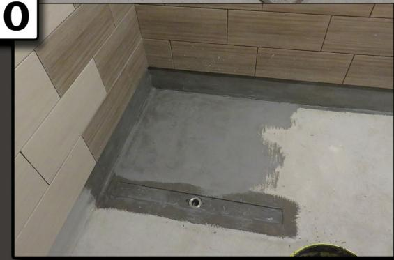
На втория ден монтираме обратно коритото на линейния сифон, обработваме го с бетонконтакт и нанасяме втори слой хидроизолация.
